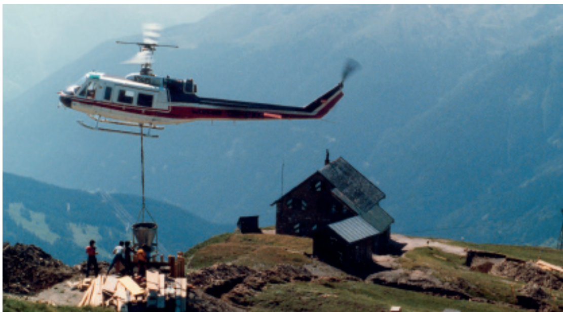
1977/78 wurde mit Hubschrauberhilfe eine Materialseilbahn erbaut, die seitdem die Hüttenversorgung gewährleistet.
