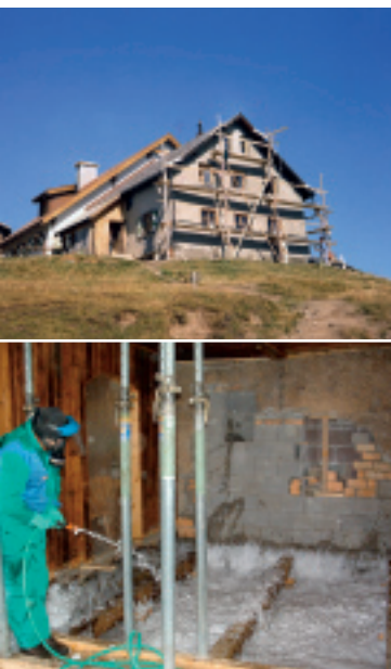
Umfangreiche Arbeiten im Rahmen der Hüttenerweiterung bzw. Sanierungsmaßnahmen im Altbau standen während der letzten 15 Jahre auf dem Programm.
