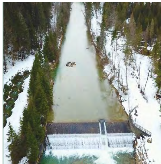
Abbildung oben links: Bild von einem Treffen mit Interessensvertretenden in der Schnalz zur Besprechung der Renaturierungsvarianten; oben: Das Schnalzwehr, welches bisher zur Sohlstabilisierung benötigt wird, wird nach der Deichrückverlegung wahrscheinlich überflüssig.
